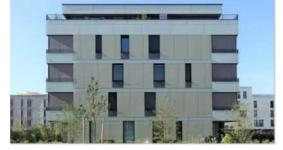
Hydrobauweise - Stahlbetonskelettbau mit Holzfassaden
